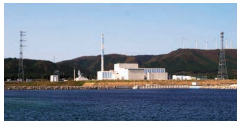
▲東北電力㈱東通原子力発電所1号機
