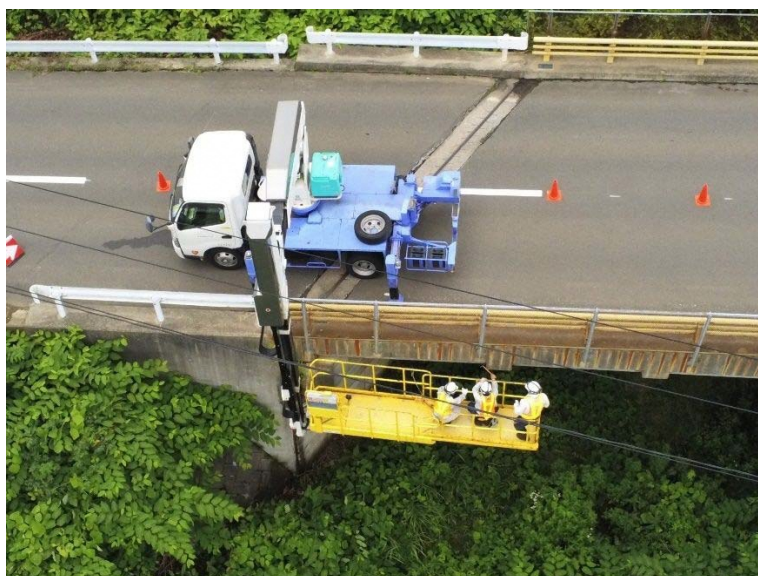
従来の点検方法（橋梁点検車）
