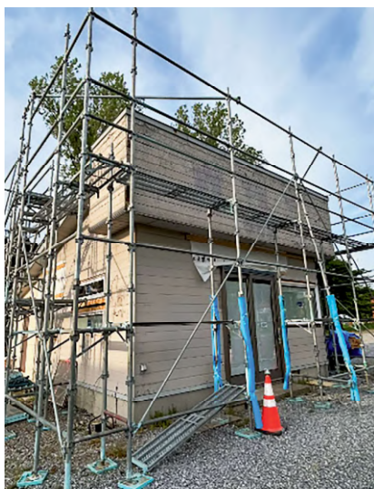
カフェ（旧長運）にリノベーションしている様子
