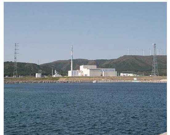
東北電力(株)東通原子力発電所1号機
