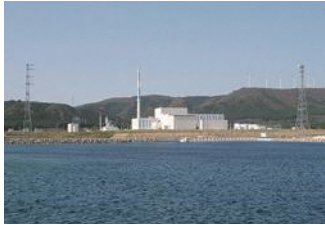
▲東北電力㈱東通原子力発電所1号機
