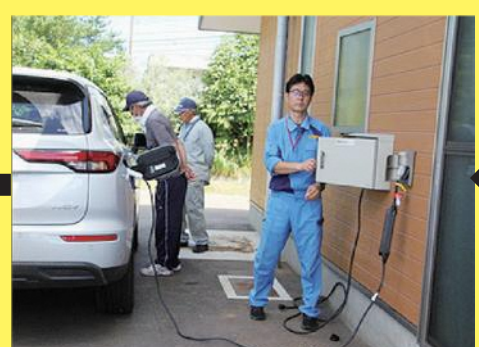
東北電力株式会社による施設から電気 自動車への電源供給
