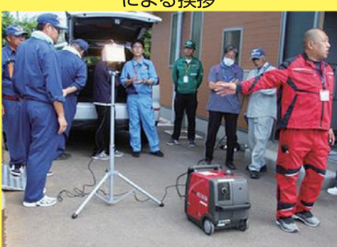
発電機から施設への非常用発電供給及 び投光器の操作訓練
