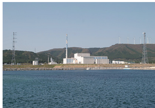
▲東北電力㈱東通原子力発電所1号機
