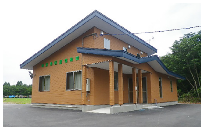
新設された避難施設(岩屋)
