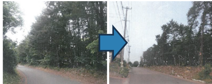
道路敷の危険な立木の伐採
