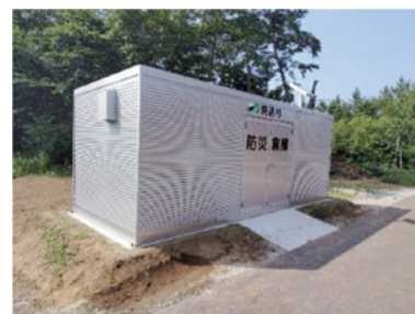
防災倉庫の設置
