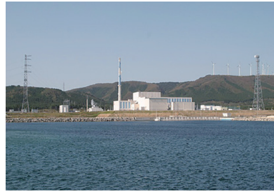
▲東北電力㈱東通原子力発電所1号機
