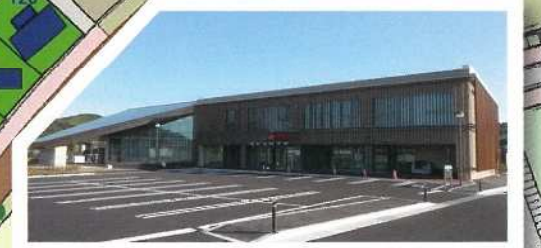
東通原子力発電所立地地域事務所
