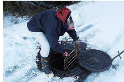
現場で作業する様子
