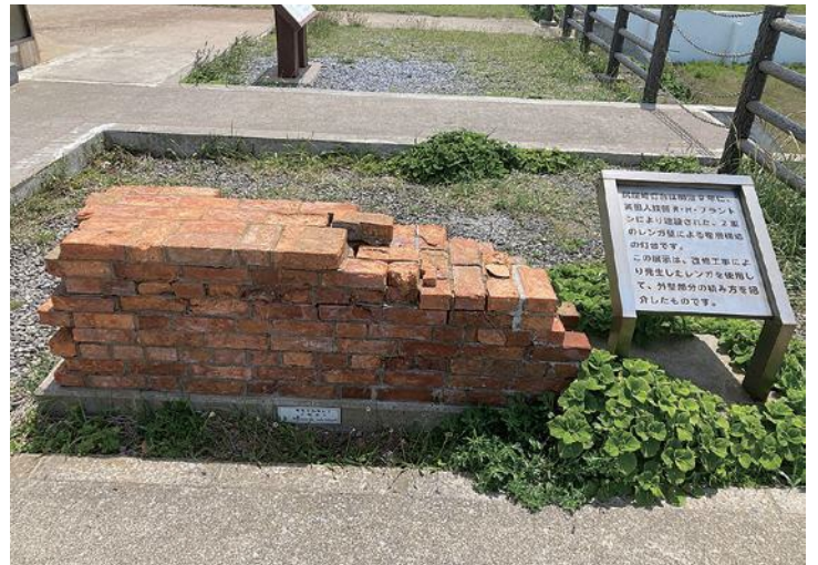
複数構造のレンガ壁を見ることができます
