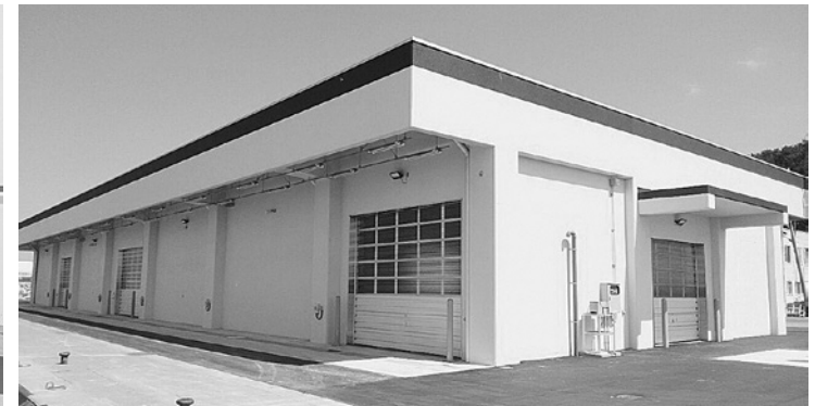
新荷捌施設外観
