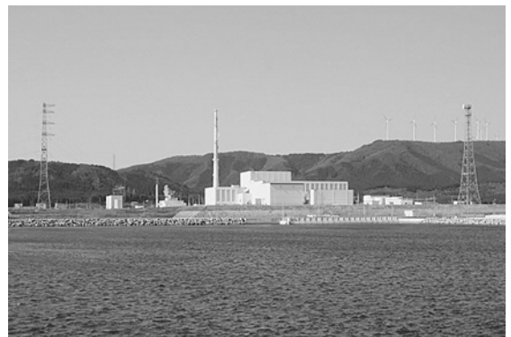
▲東北電力㈱東通原子力発電所 1号機
