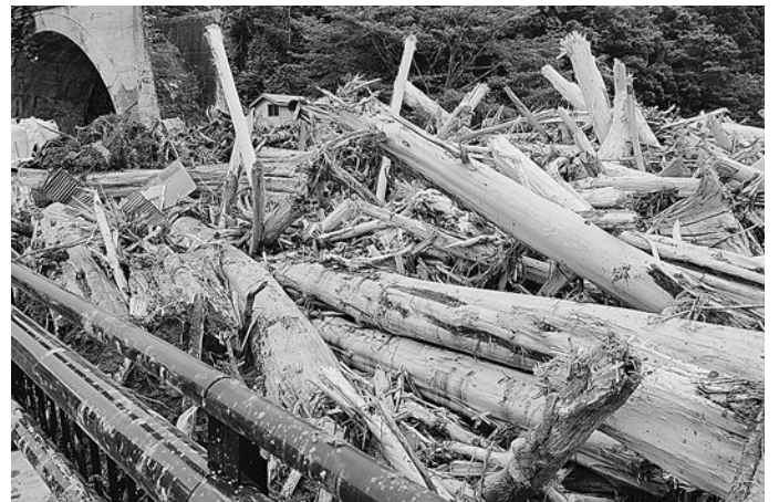
崩落した小赤川橋の脇に溜まった流木
