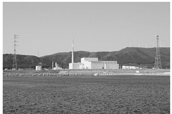
▲東北電力㈱東通原子力発電所 1号機
