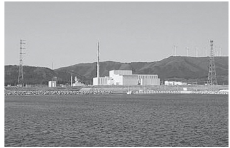
▲東北電力(株)東通原子力発電所1号機
