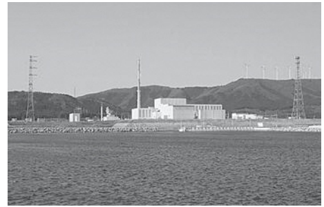
▲東北電力(株)東通原子力発電所1号機
