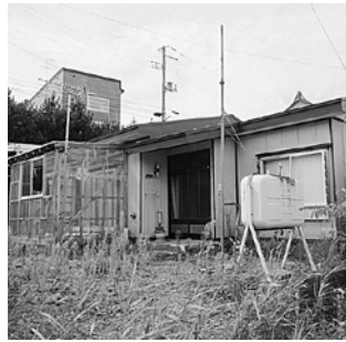
※旧老部小学校教員住宅
