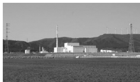
▲東北電力㈱東通原子力発電所1号機
