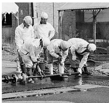
給水管の復旧を実演
