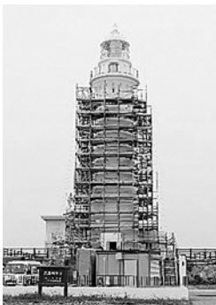
工事中は櫓のような足場が設置されました
