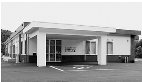
特別養護老人ホーム「いちいの森」施設外観
