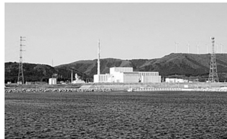
▲東北電力㈱東通原子力発電所1号機
