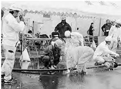
給水管の復旧を実演
