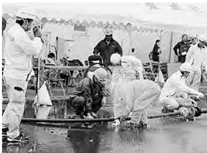
給水管の復旧を実演
