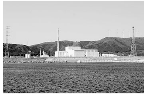
▲東北電力(株)東通原子力発電所1号機
