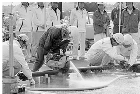
給水管漏水復旧・給水訓練
