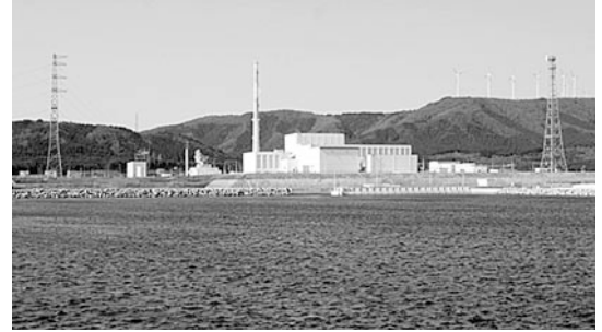
▲東北電力(株)東通原子力発電所1号機
