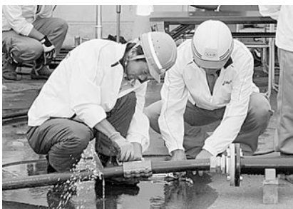
水道管漏水復旧訓練
