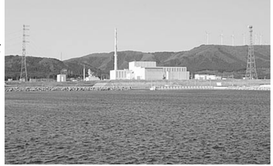
▲東北電力(株)東通原子力発電所1号機
