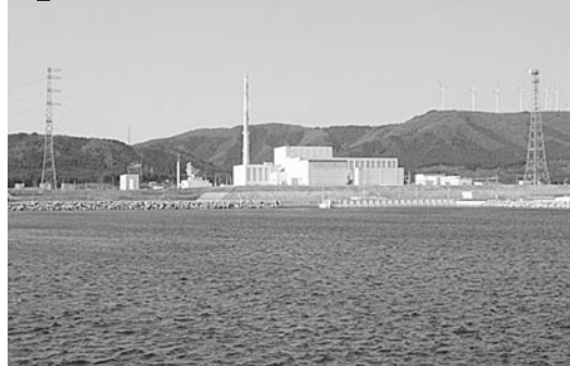
▲東北電力(株)東通原子力発電所1号機
