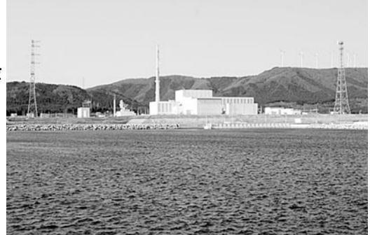
▲東北電力(株)東通原子力発電所1号機
