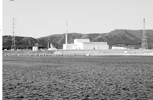
▲東北電力㈱東通原子力発電所1号機
