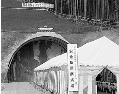
安全祈願祭会場の白糠坑口前
