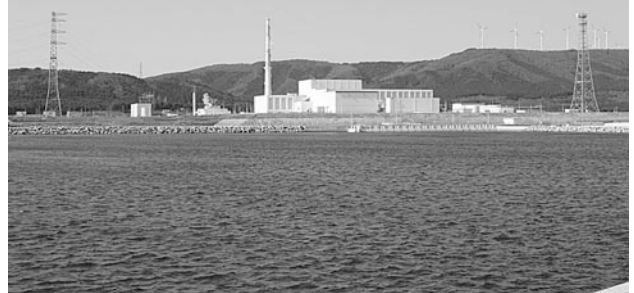
▲東北電力㈱東通原子力発電所1号機
