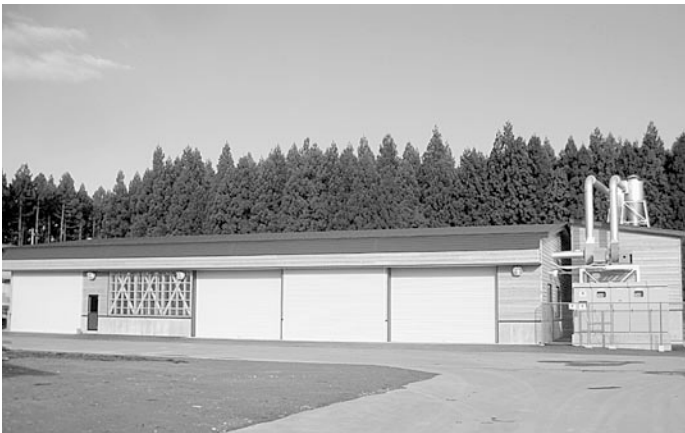
完成した第2製材工場
