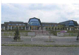
東通小学校前面 の歩道には、村の木 「イチイ」と「ヤマ ボウシ」が植えられ ています。
