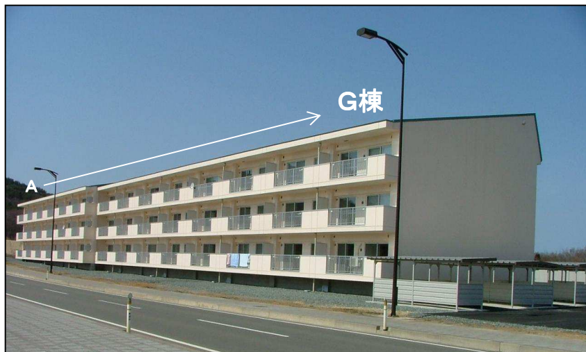
南(道路)側からの全景
