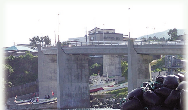
漁港から見た橋
