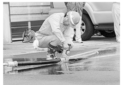
給水管漏水復旧訓練
