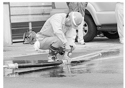
給水管漏水復旧訓練
