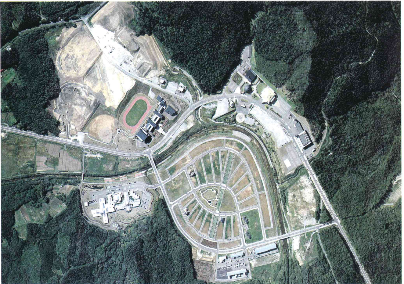
統合中学校建設予定地（写真左上）
